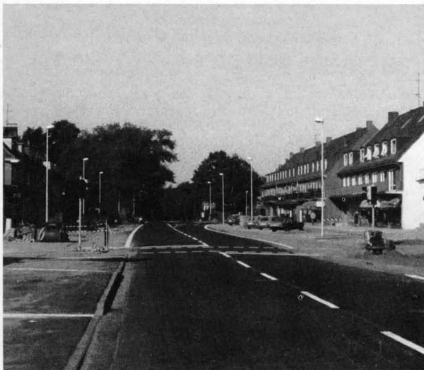
Der ausgebaute Eilbergweg
