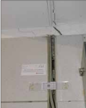
Ein Riss mit Mess-Skala
