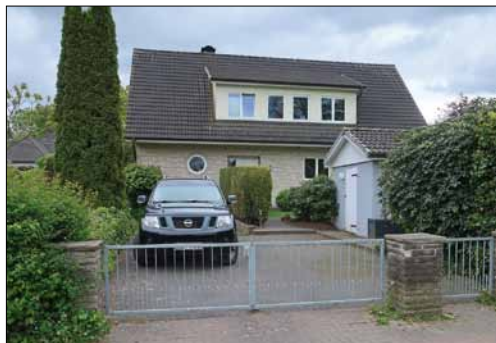
Das Wohnhaus heute nach dem Ausbau
