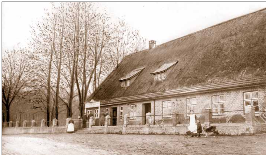
Das Gasthaus Mühlendamm, 1909
