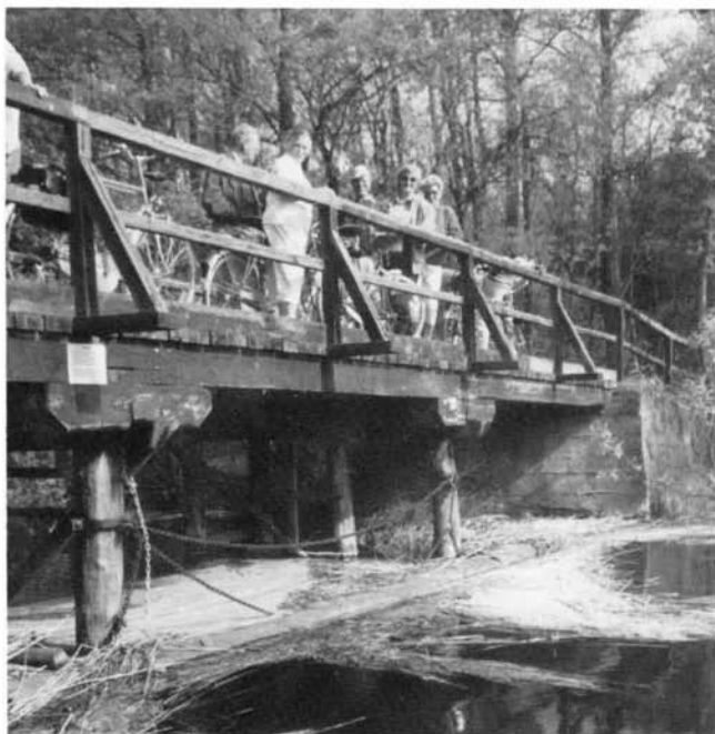
Verschlaufpause auf der Brücke Aufnahme J. Wergin
