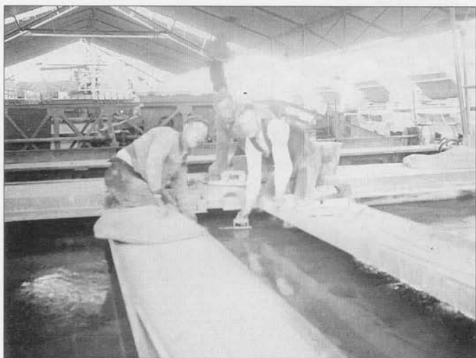
Autobahnbau, der Schliß für die Betonfahrbahn
