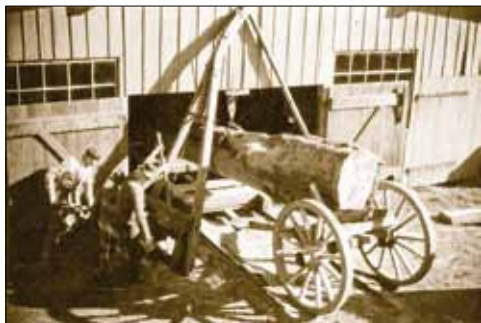
Die Arbeiter schieben einen Baumstamm vor die Säge.
