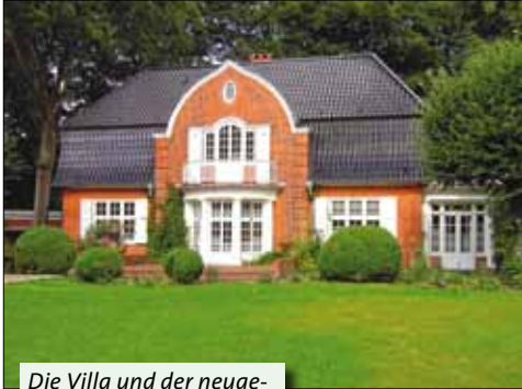
Die Villa und der neuge- staltete Eingangsbereich
