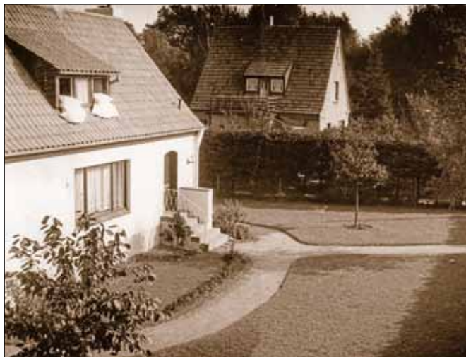
Die Häuser Nr. 49 und Nr. 51 (Tischer und Feilck) in den 60er-Jahren. Beide Häuser wurden abgerissen und durch Neubauten ersetzt.
