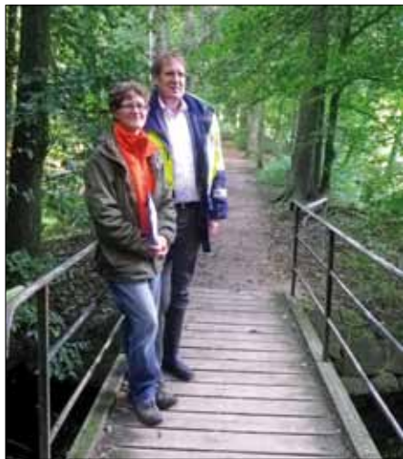
Die Leiterin des Umweltamtes Heinke Mulsow und Bürgermeister Janhinnerk Voss auf der instandzusetzenden Brücke
