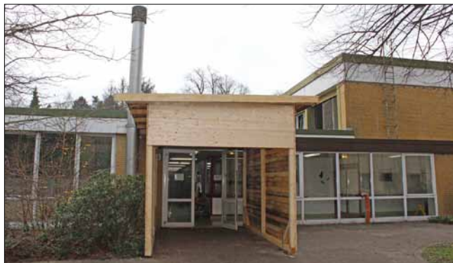
Das THW hat vor dem Eingang des Impfzentrums einen überdachten Warteraum aufgebaut.
