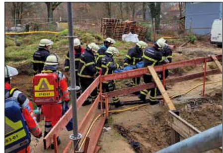
Tragehilfe beim Neubau Lungenklinik
