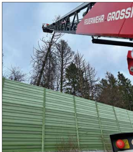
Lärche Lärmschutzwand BAB
